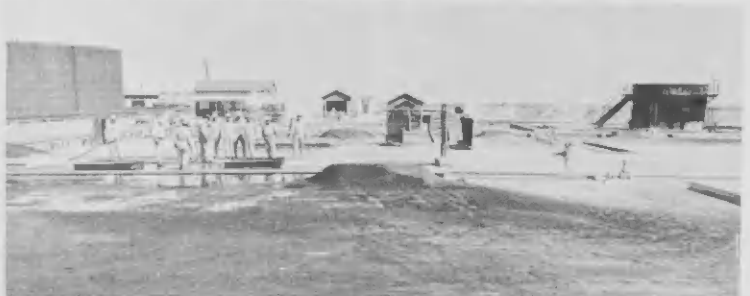
Partial view of the new Fire Training Ground, looking east. Vista parcial di Sitio di Entrenamento pa paga candela.
